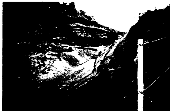
写真2/太郎坊駐車場側の崩落場所
